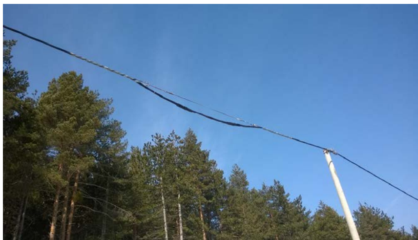
Slika 2. fotografija spojnice u provjesu na UKB Prusac- Ajvatovica
